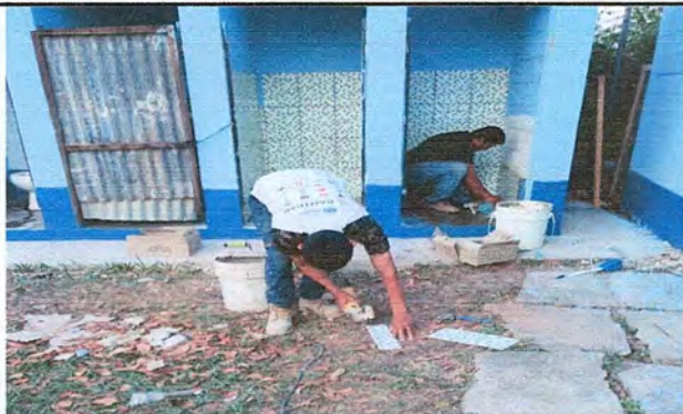
Foto1: Mejoramineto de servicio sanitario, colocación de azulejo, renovacion de pintura en puertas y cambio de techo.
