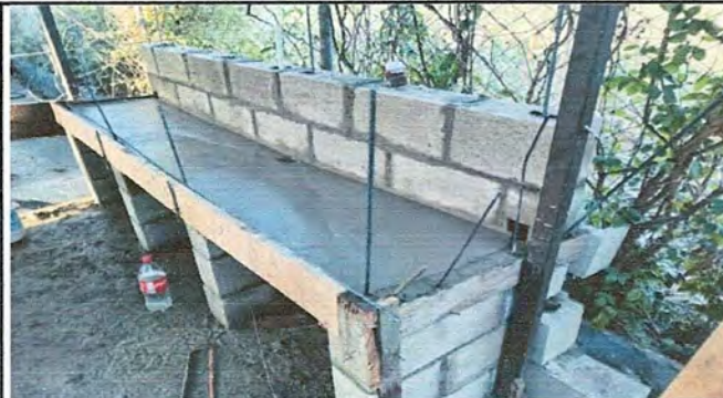
Foto 2: Realizacion de 3 lavamanos de cemento.
