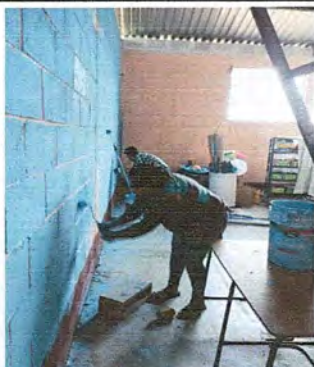
Foto 3:Mejoramiento de pintura de la parte inferior y exterior de aulas y direccion.
