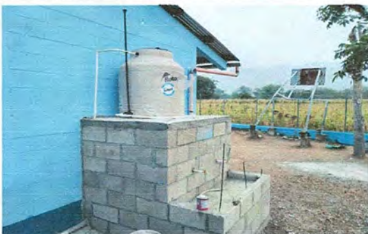
Foto5: Proceso del abastecimiento de agua de block, colocacion de rotoplas, chorros y tuberias
