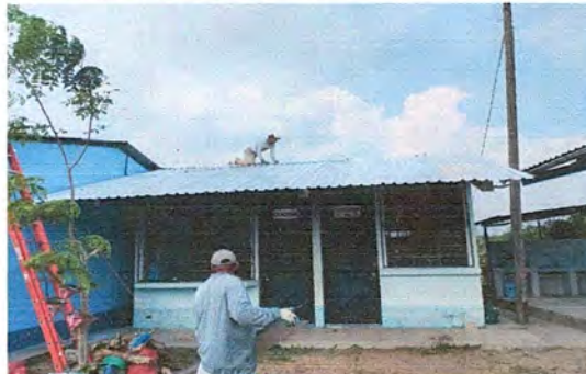
Foto 6: Cambio de techo de cocina y direccion, reposiscion de pintura en pared, anticorrosivo en balcones y puertas
